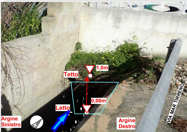
Altezza dell'acqua nell'alveo in condizioni normali nel periodo invernale lontano da piogge h = 0,05 m
